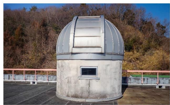
東条中学校 天体観測ドーム (直径3.2m 高さ3.5m)
