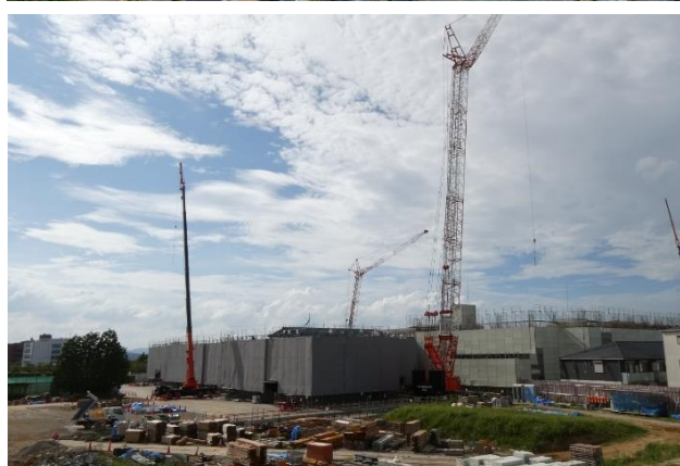
〈8/18 以前のカセ池から撮影した工事の様子〉
